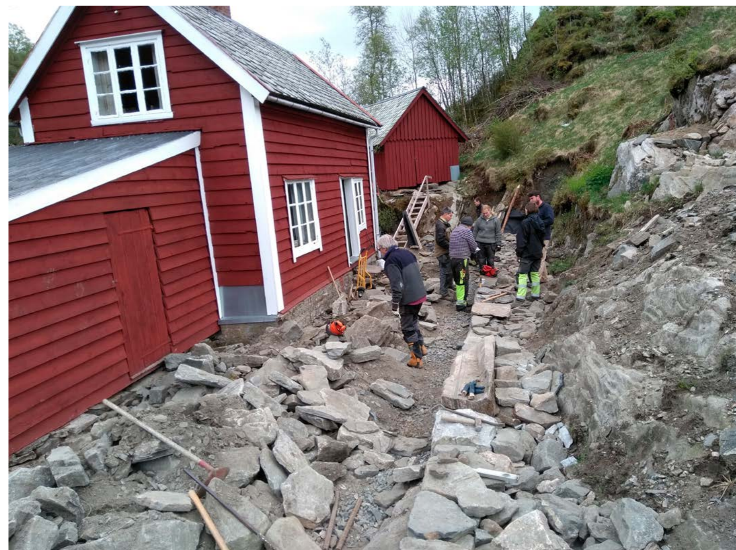
Det er stor interesse for å lære mer om eldre tradisjonelle håndverksteknikker, som her på kurs i tradisjonell tørrmuring, Koppen på Osterøy. Foto: Magne Raknes
