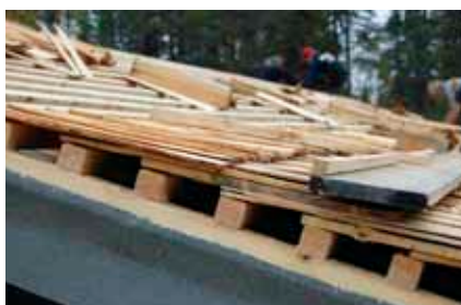
Snitt som viser de tre lagene med stikker dette stikketaket har.
