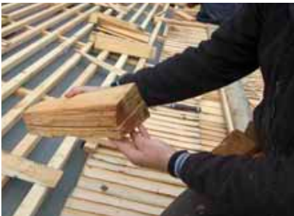
Taket var lagt med innstikksida ned. Her vurderer håndverkeren stikkeretning og forbereder spikring.
