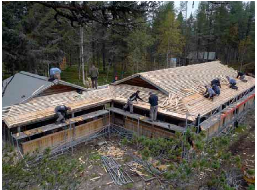
Under arbeid med tekking høsten 2011.
