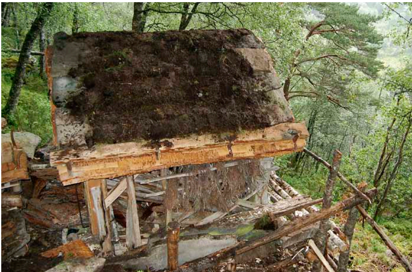
Taket er tekket. Arbeid med yttervegger gjenstår.
