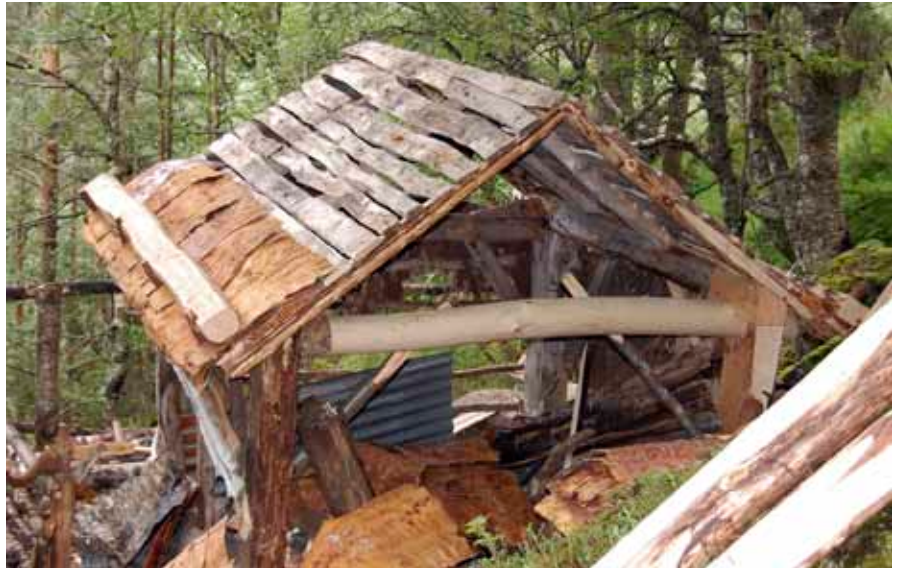
Bildet viser Jedlaløo etter at grindverket er satt i stand og tekkearbeidet så vidt er igangsatt.
