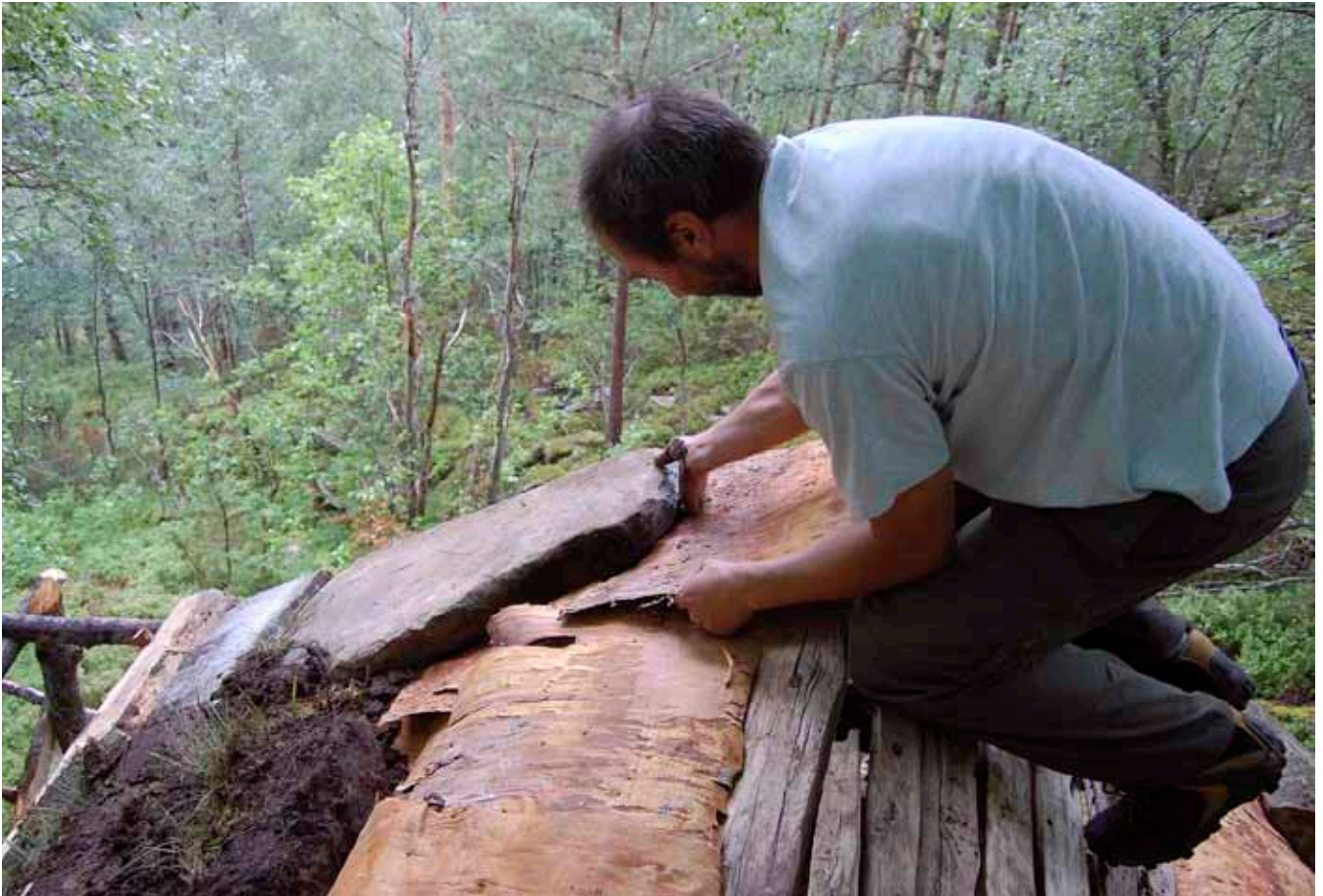
Her tilpasses velessesteiner mot røstet på løa og slik at de ligger godt mot hverandre.
