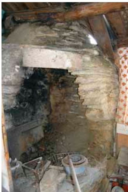
Innvendig ser grua relativt bra ut.
