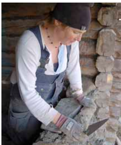
Muring med leirbruk på Rasmusvollen. Tradisjonshåndverker Johanna Henriksson i arbeid.
