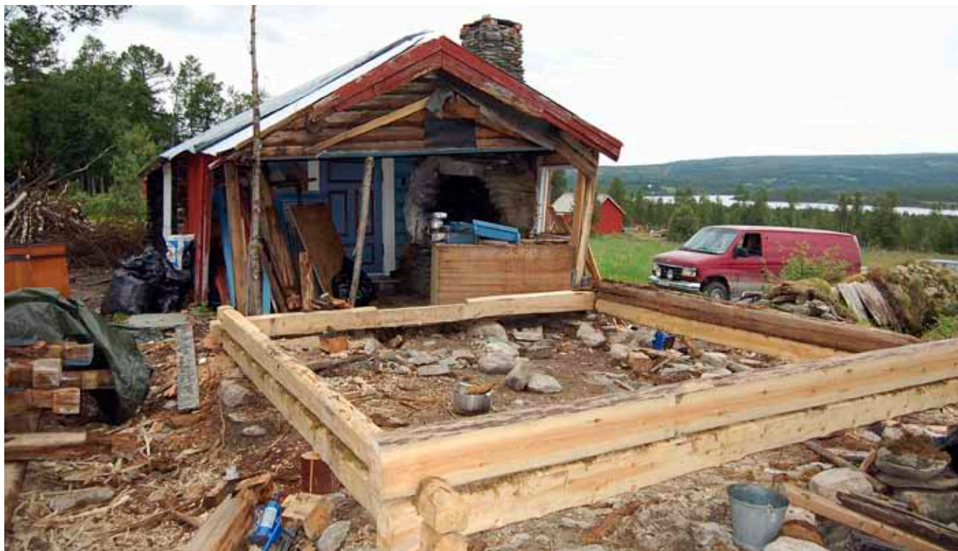
Under istandsetting av den ene delen av seterstua. Ildstedsanleggets plassering vises godt.
