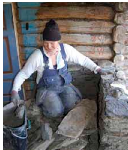
Det er viktig at man har steinmaterialer som passer til vangenes dimensjoner
