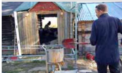
Blanding av mørtel.
