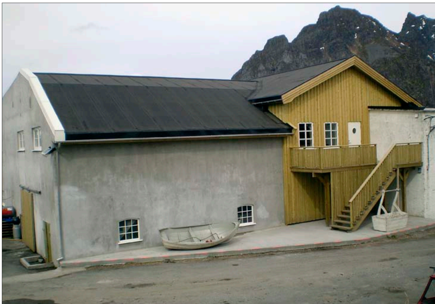
Uheldig bruk av materialer og uheldig utforming i forbindelse med utbedring. Foto: Kulturminnefondet.
