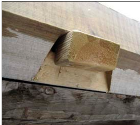
Bruk av trykkimpregnerte materialer på torvhovdsstokk og raftsperer. Foto Kulturminnefondet.
