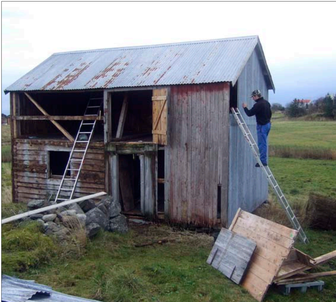
Under istandsetting av fjøs. Bildet viser god gjenbruk av opprinnelige materialer. Foto fra rapport.
