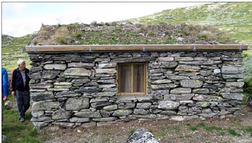
Steinbu etter istandsetting. Foto: Prosjektleder.
