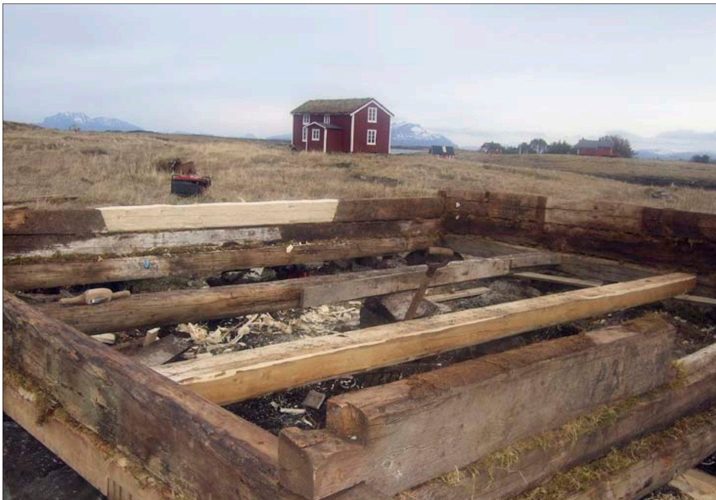
Under istandsetting av fjøs. Foto fra rapport.
