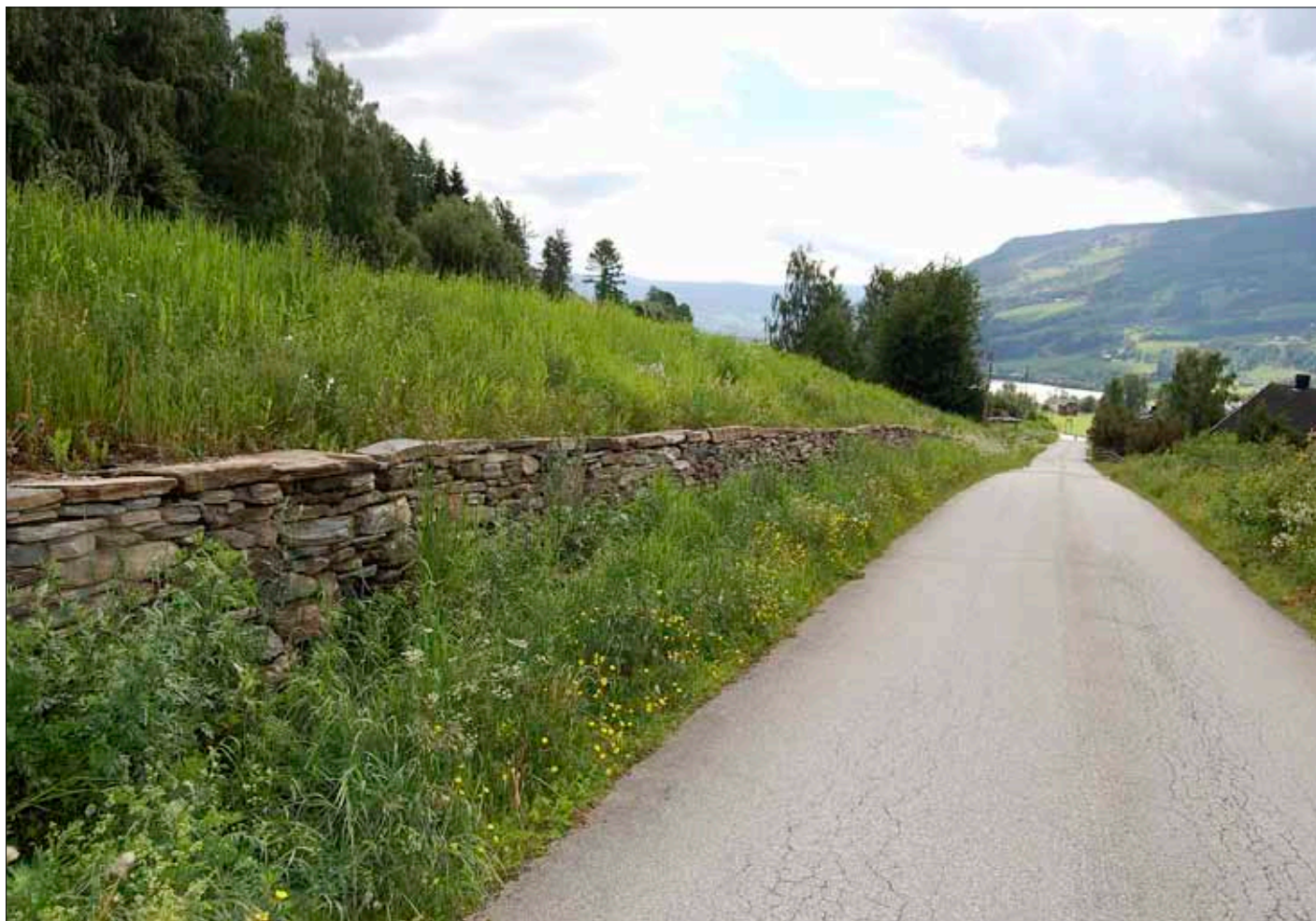
Murverket ble murt i tråd med opprinnelig utførelse
