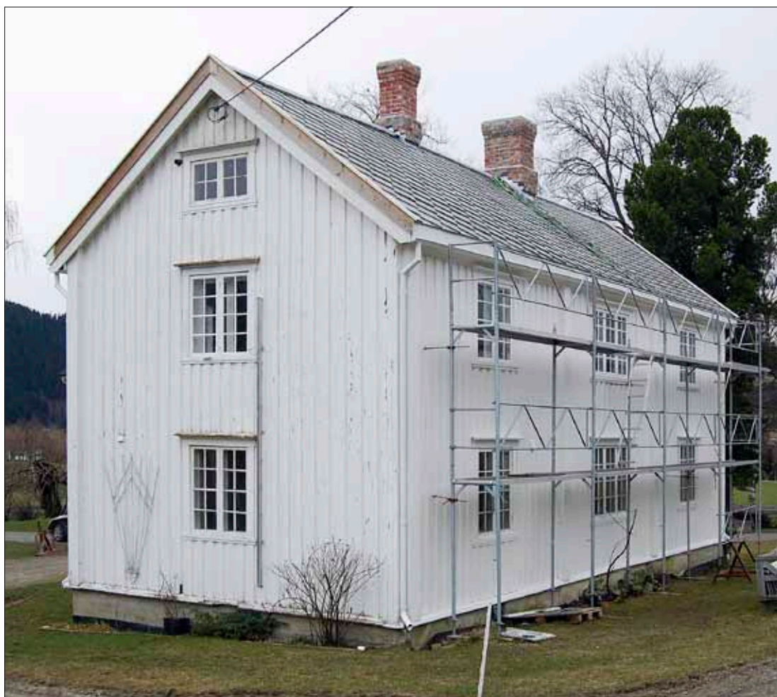
Istandsetting av drengestua på Fogdegårdstunet bidrar til å bevare bygningen og firkanttunet
