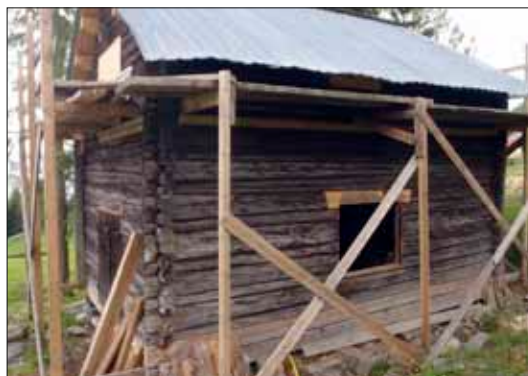
Smie under istandsetting. Framtidig bruk skal være enkel overnatting
