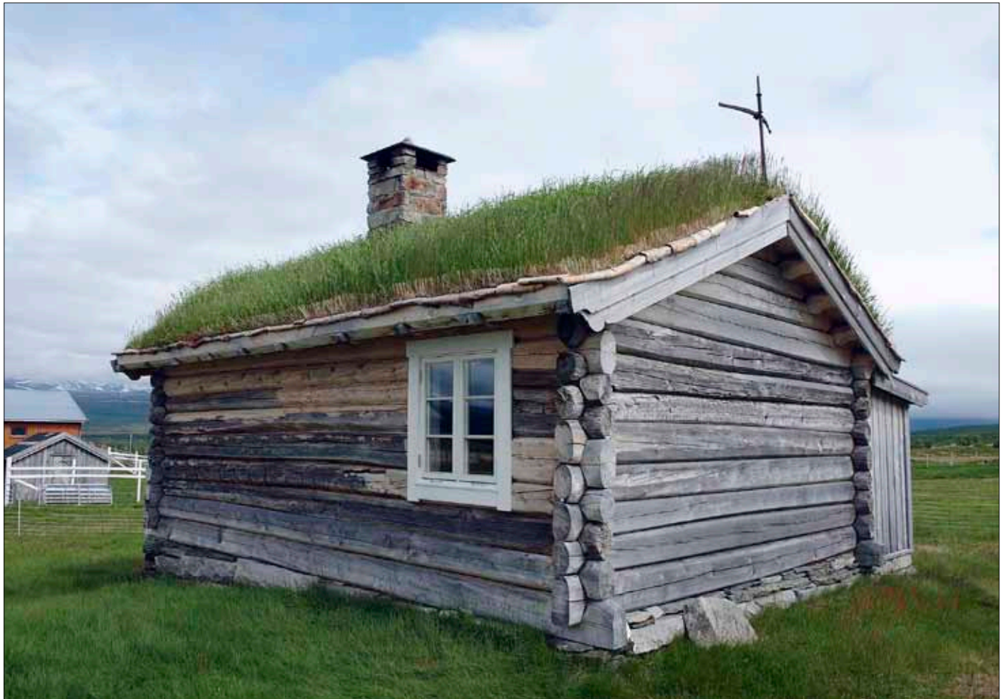
Etter istandsetting med et kors på mønet
