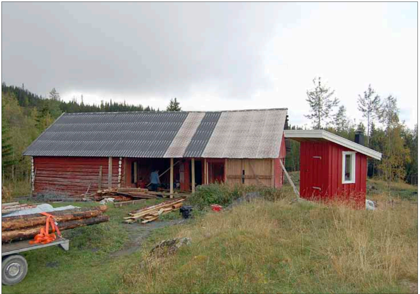
Løe på Høgkorsplassen under istandsetting
