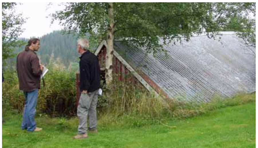
Jordkjeller bygd inn i terrenget overdekket med jord og med saltak. Eksempel fra Sør-Trøndelag.
