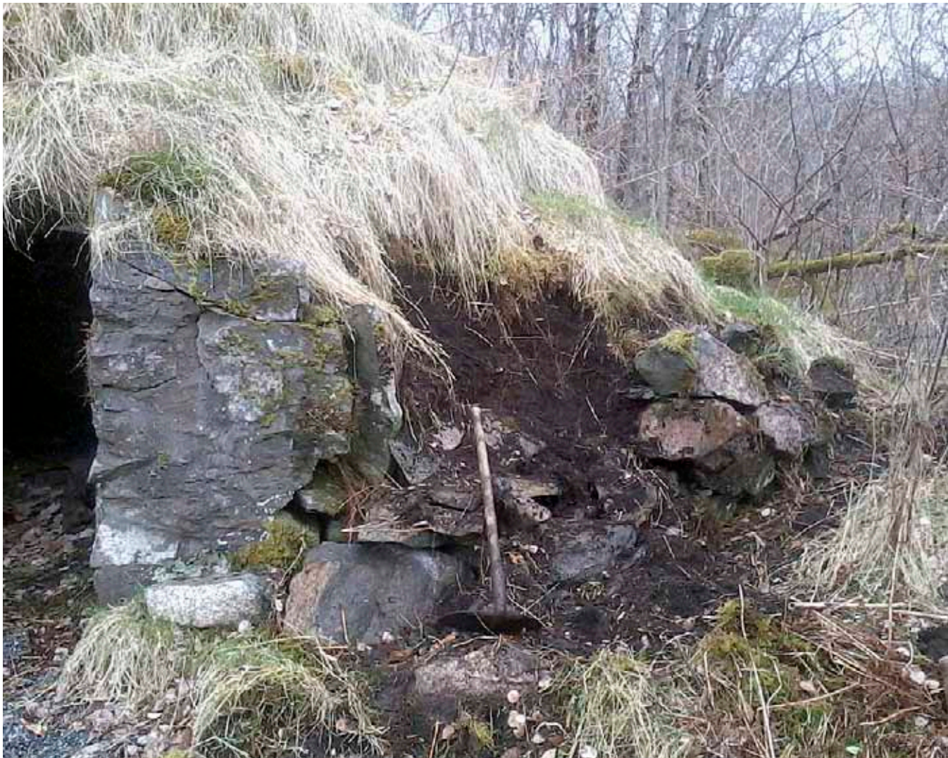
Murverket ved døra ble demontert, terrenget rettet opp for ny yttermur ble bygd.
