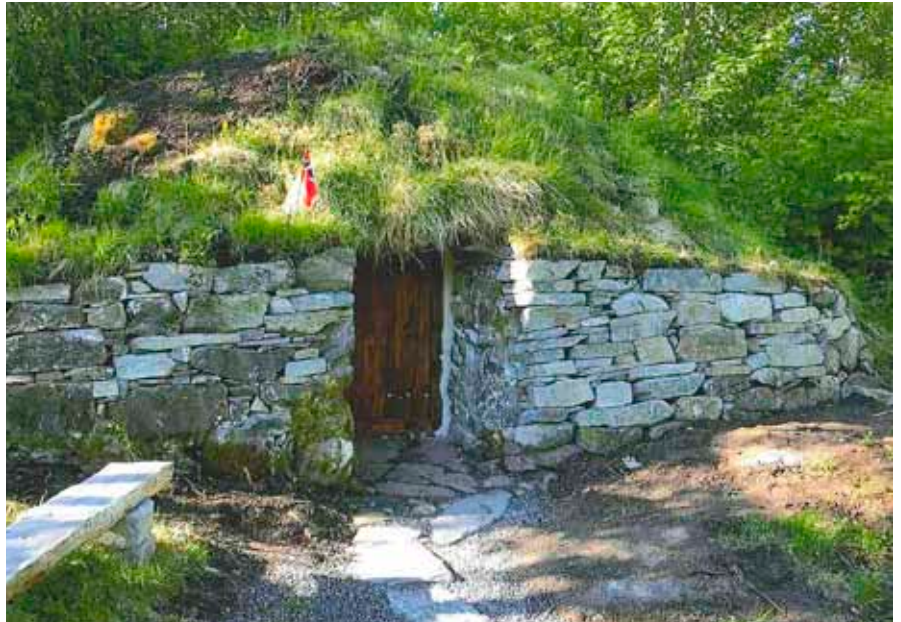
Kjeller etter reparasjon og klar til bruk.
