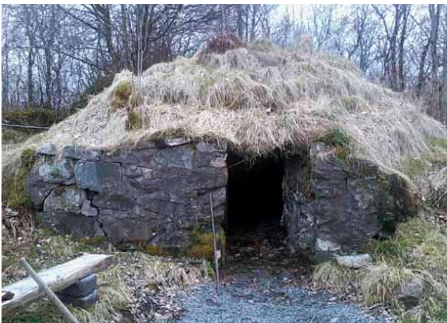
Jordkjelleren før istandsetting.
