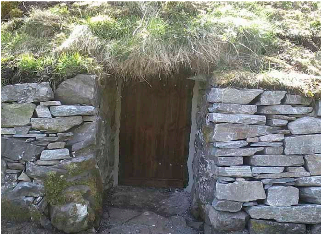
Utsnitt som viser inngangspartiet til kjelleren ferdig istandsatt.
