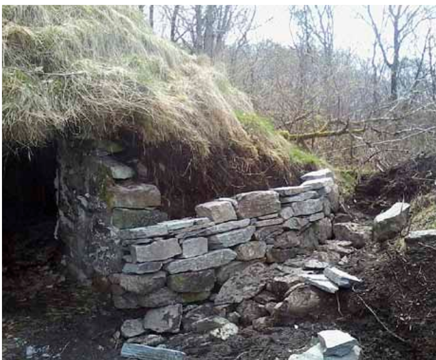
Bildet viser gjenoppmuring.
